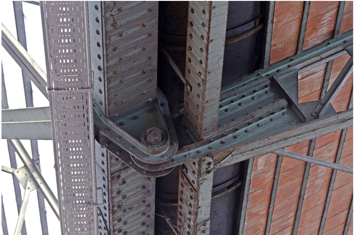
Detail van het scharnierende gebinte van de sheddaken.
