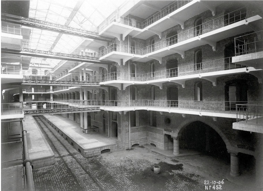
Oktober 1906: het interieur van het Koninklijk Pakhuis met zijn over vier niveaus omlopende galerijen in de afwerkingsfase.
