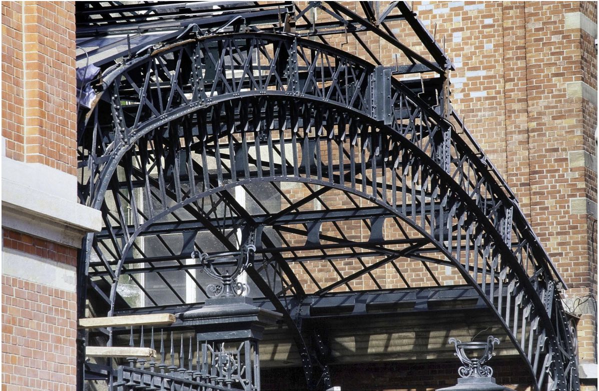
Detail van het gebinte van het glazen dak.
