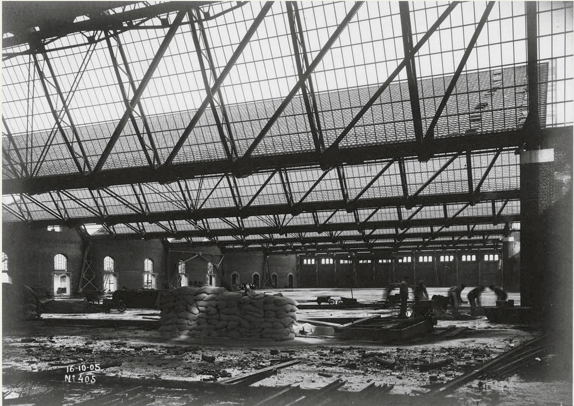
Het skelet van entrepot A is voltooid en de zuidelijke dakhellingen van de sheds zijn al met dakpannen bedekt.
