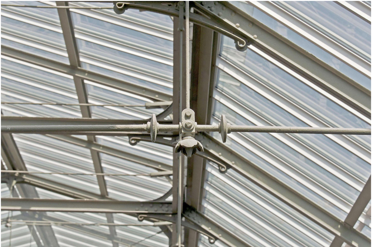
Detail van het metalen gebinte van het glazen dak.
