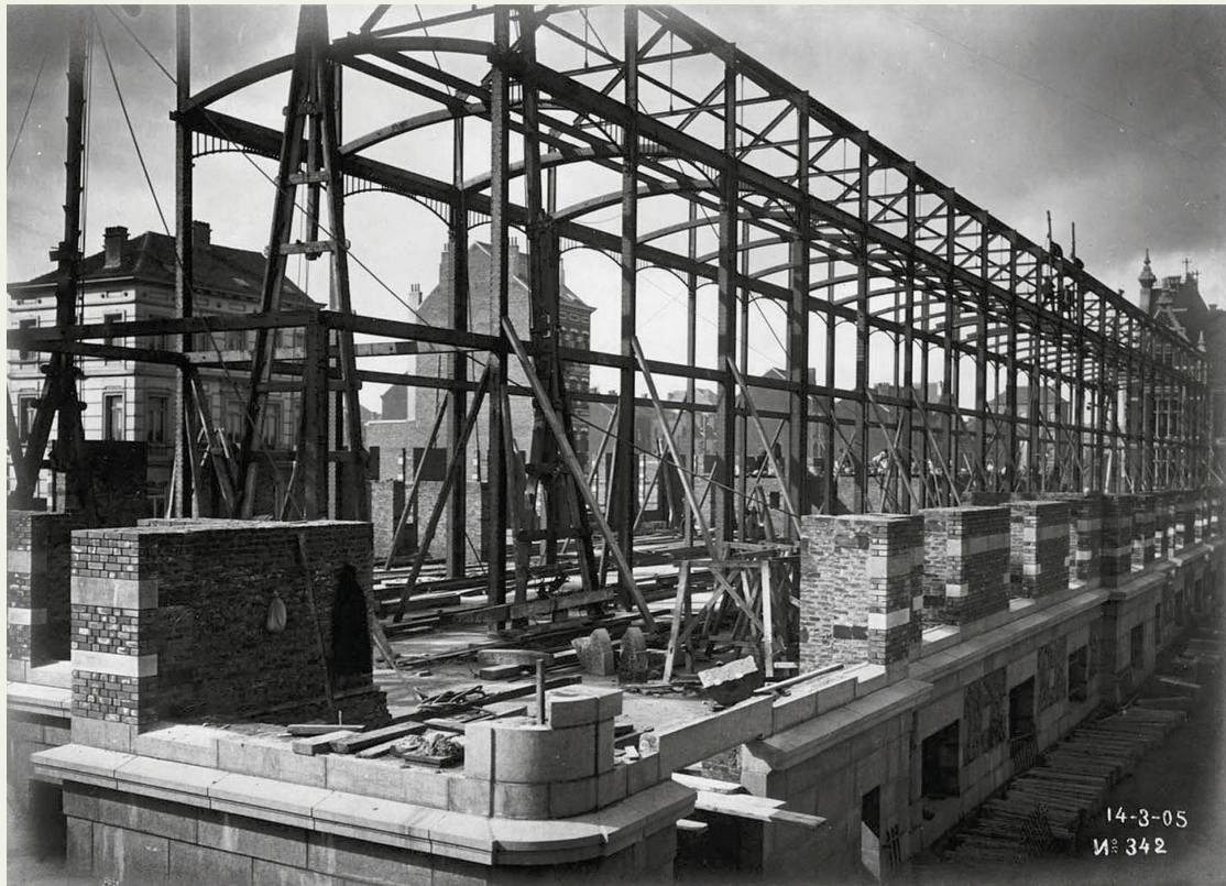
Bouw van het metalen skelet van de centrale hal van het douanegebouw.
