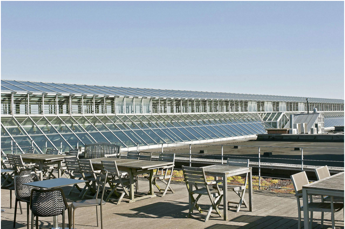
Het glazen dak van het Koninklijk Pakhuis.
