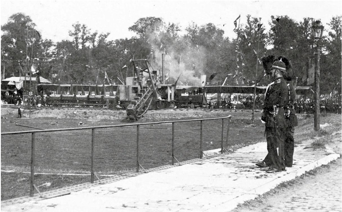
De krachtige graafmachine boort het eerste gat te midden van een dikke regen van stof op de dag van de officiële opening van de bouwwerf.
