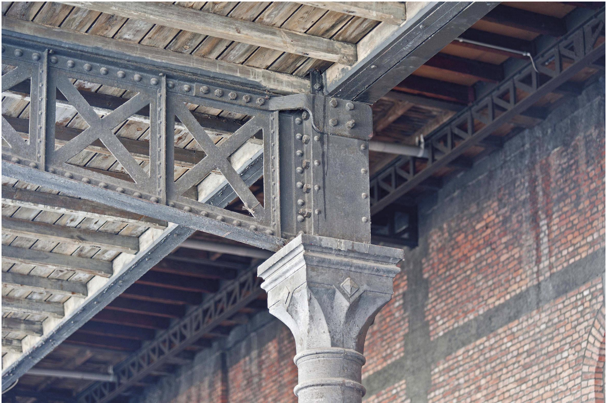
Kapiteel van een van de kolommen die het dak van het perron dragen.
