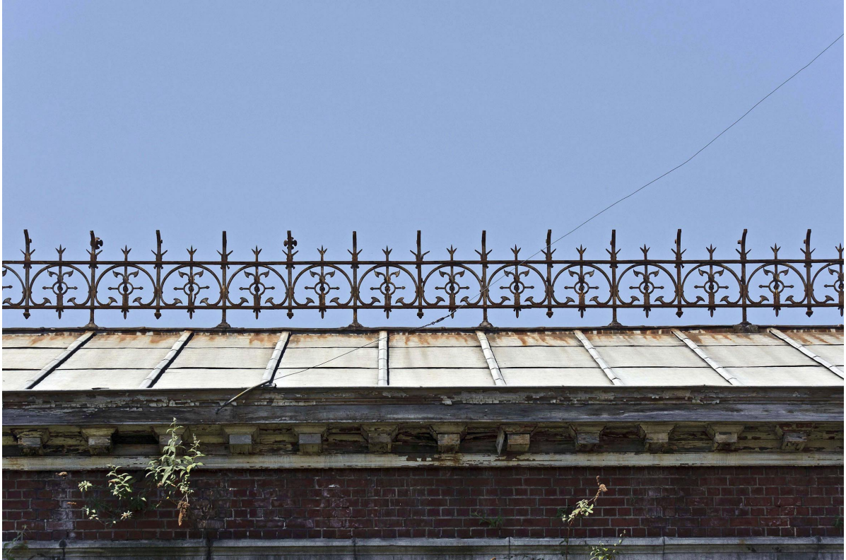
Smeedijzeren decoratie op de nok van het dak van de elektriciteitscentrale.
